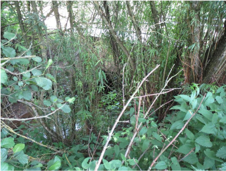
Durchlass; Ufer unterbrochen
