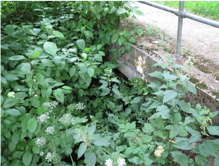
Durchlass; Ufer unterbrochen
