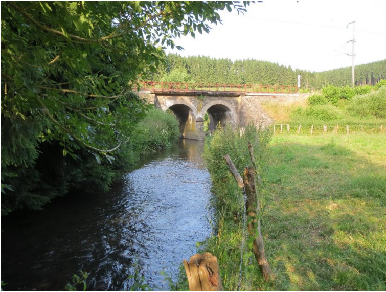
Durchlass; Ufer unterbrochen
