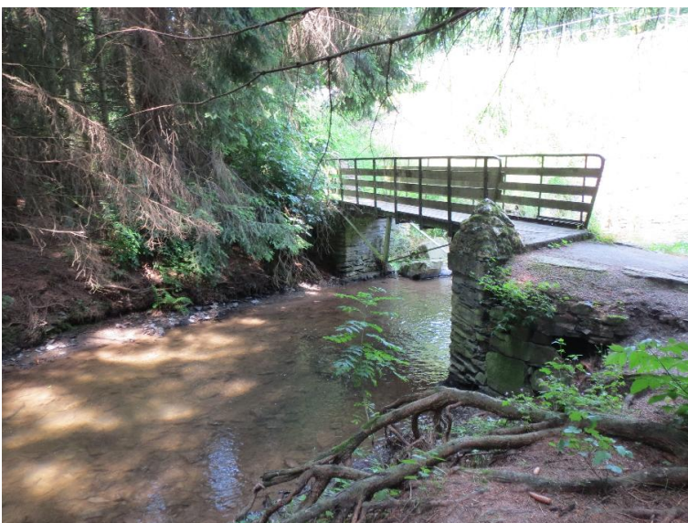
Durchlass; Ufer unterbrochen
