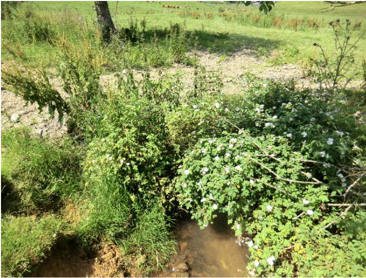
Durchlass; Ufer unterbrochen
