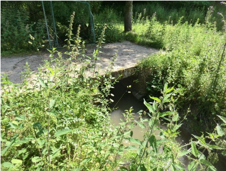
Durchlass; Ufer unterbrochen
