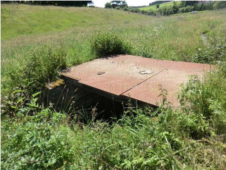
Durchlass; Ufer unterbrochen
