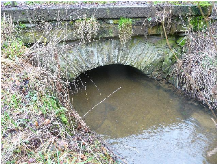
Durchlass; Ufer unterbrochen
