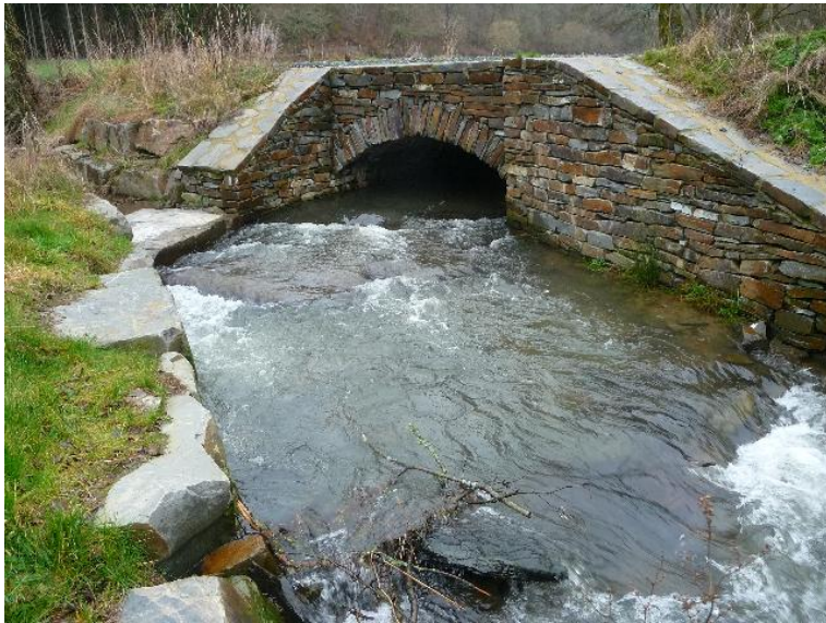
Durchlass; Ufer unterbrochen
