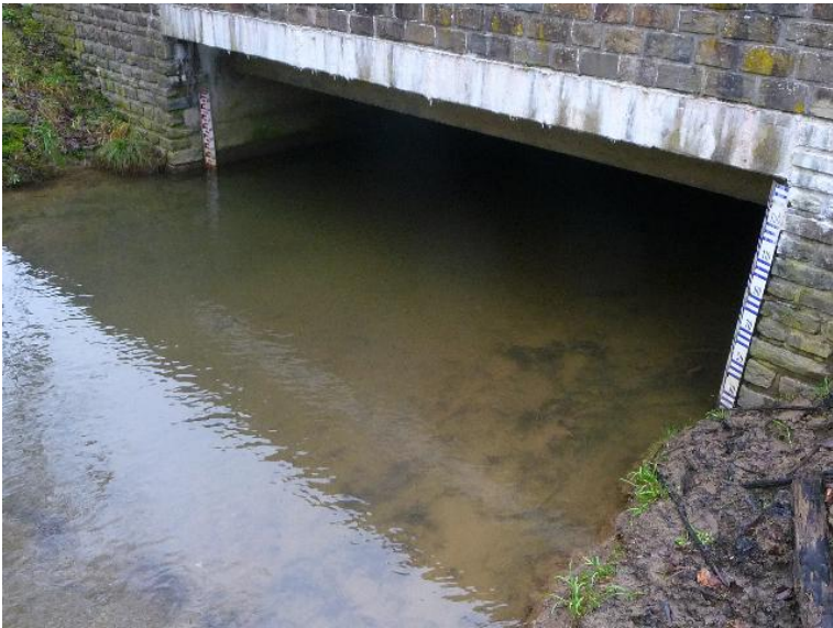
Durchlass; Ufer unterbrochen
