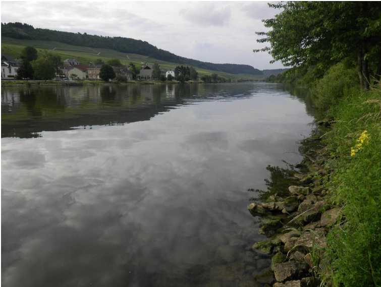
Uferverbau Steinschüttung
