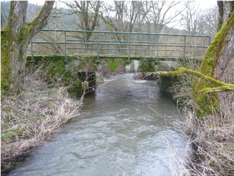
Durchlass; Ufer unterbrochen
