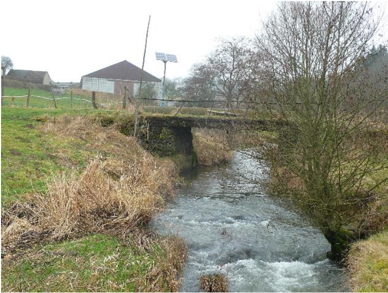
Durchlass; Ufer unterbrochen
