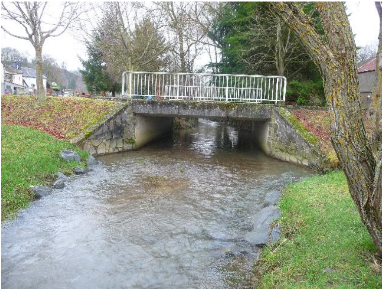
Durchlass; Ufer unterbrochen
