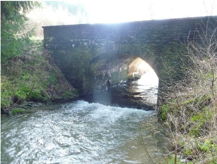
Durchlass; Ufer unterbrochen
