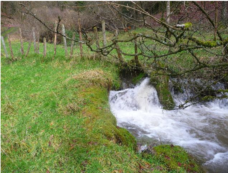
Durchlass; Lauf verengt
