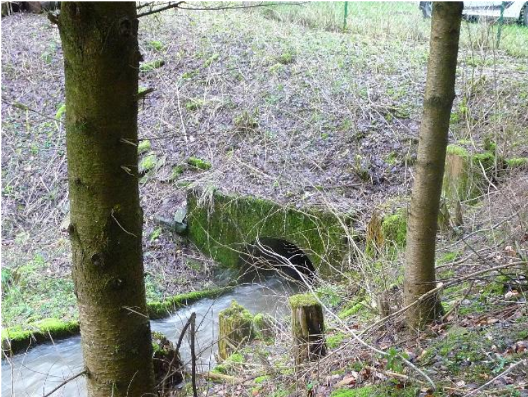
Durchlass; Ufer unterbrochen
