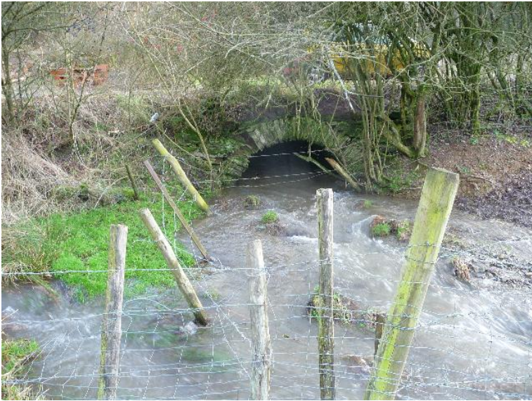
Durchlass; Ufer unterbrochen
