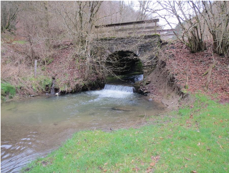
Absturz; kleiner - Durchlass; Ufer unterbrochen
