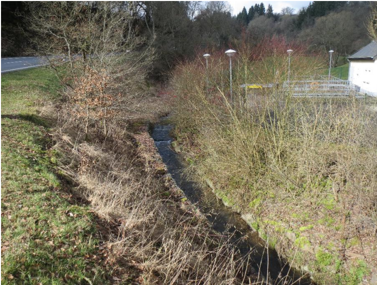
Pflaster, Steinsatz unverfugt
