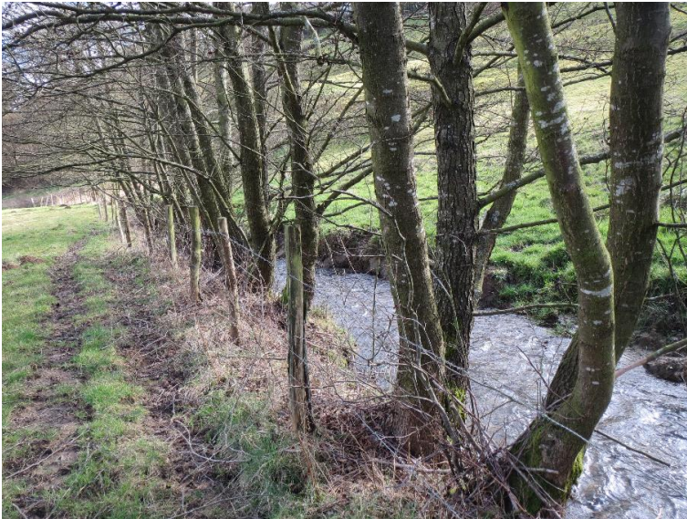
Galerie; bodenstaendig - Gruenland - Erosion
