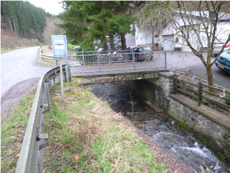
Durchlass; Ufer unterbrochen
