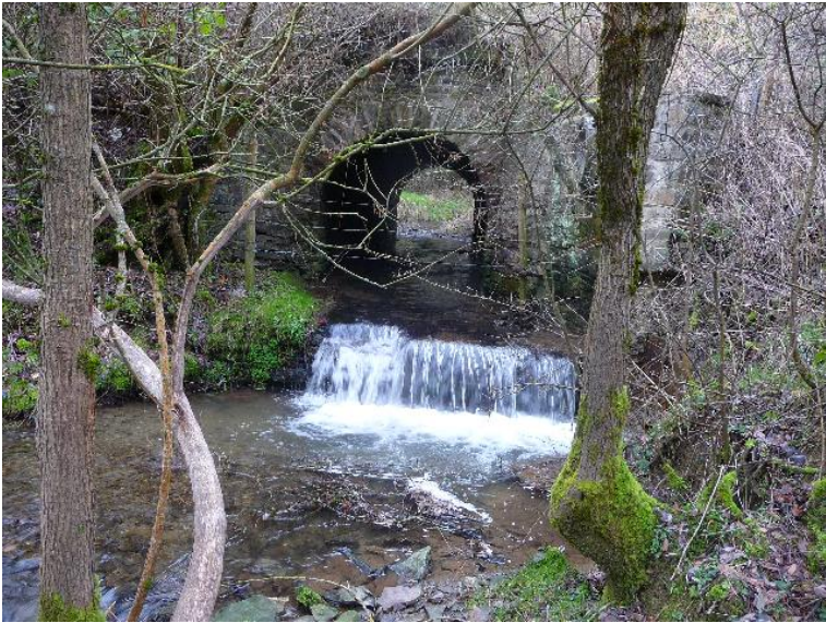
Durchlass; Ufer unterbrochen
