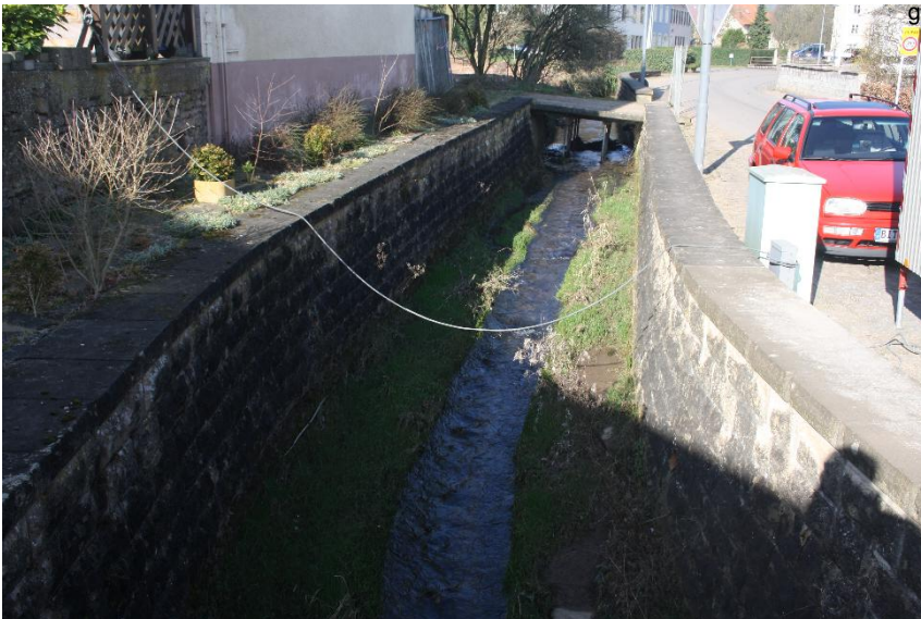
Beton, Mauer, Pflaster; verfugt
