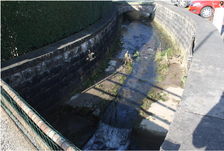
Beton, Mauer, Pflaster; verfugt
