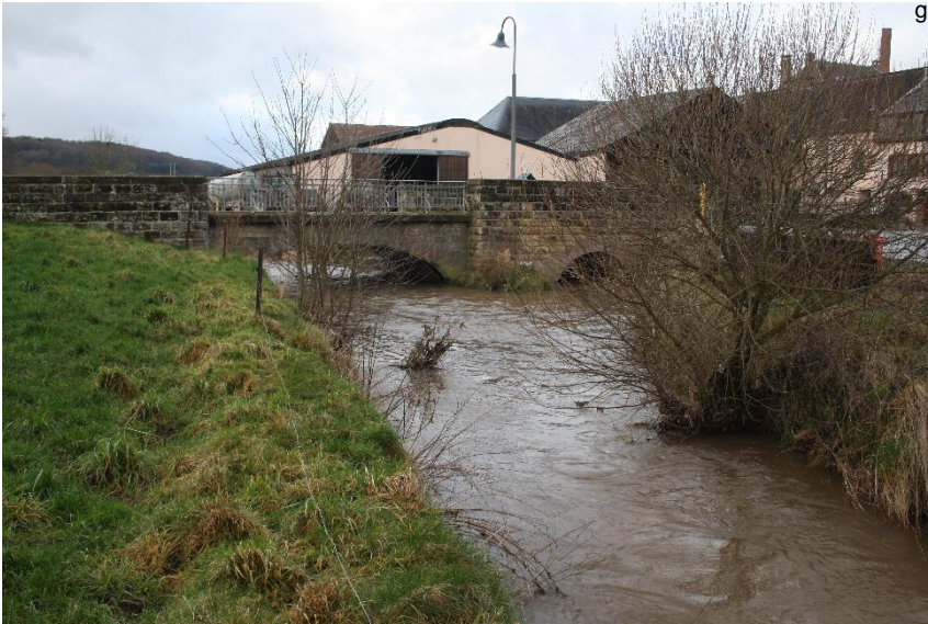
Bebauung mit Freifläche
