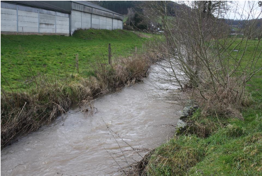
Bebauung mit Freifläche
