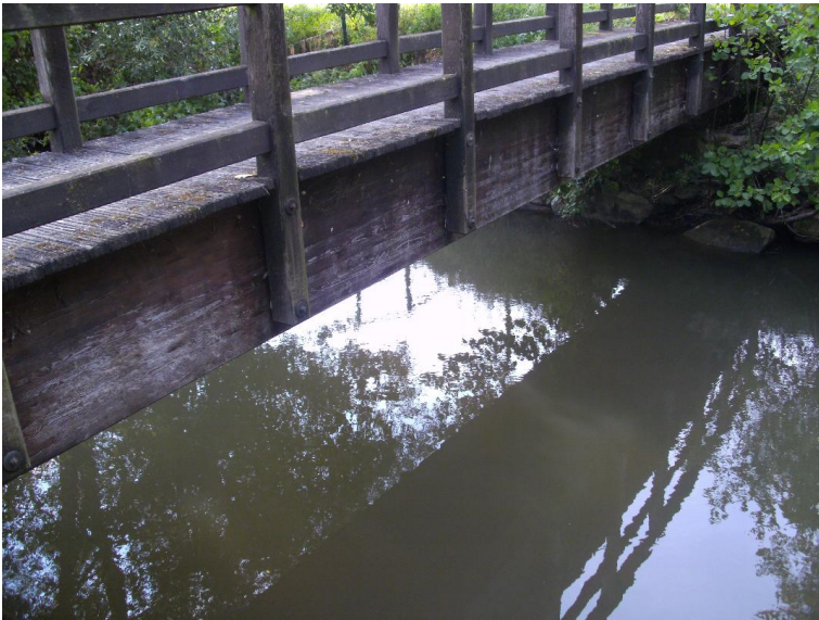
Durchlass; Ufer unterbrochen
