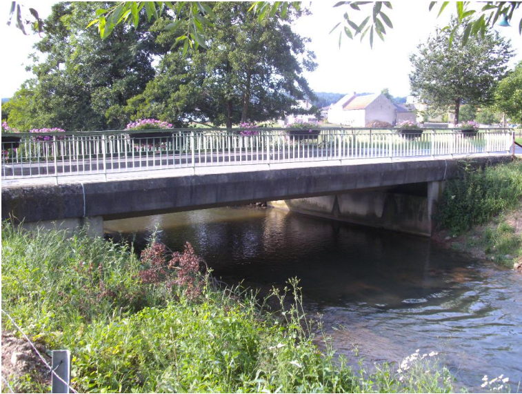
Durchlass; Ufer unterbrochen
