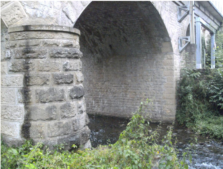
Durchlass; Ufer unterbrochen
