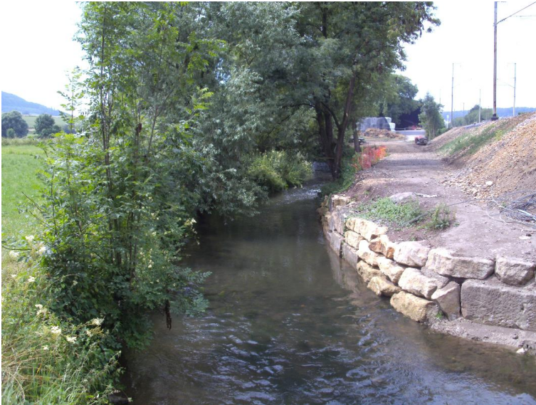
Uferverbau Steinsatz unverfugt
