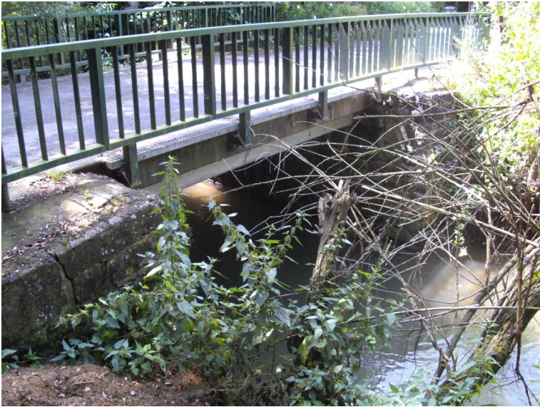
Durchlass; Ufer unterbrochen
