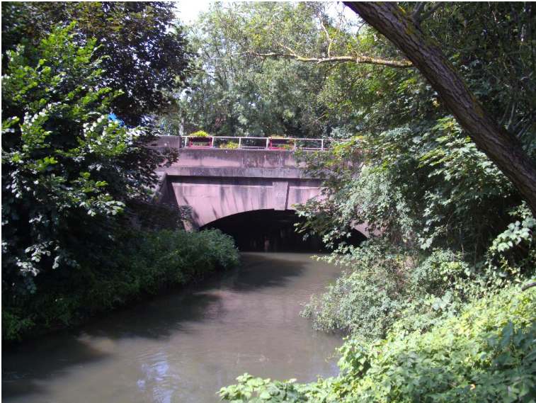
Durchlass; Ufer unterbrochen
