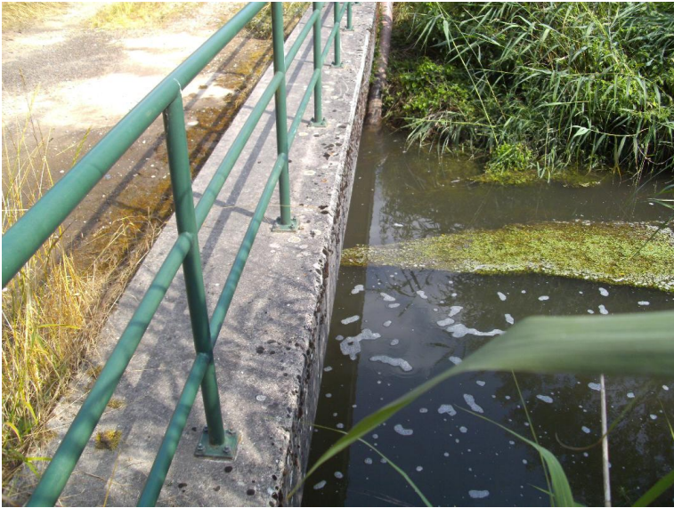
Durchlass; Ufer unterbrochen
