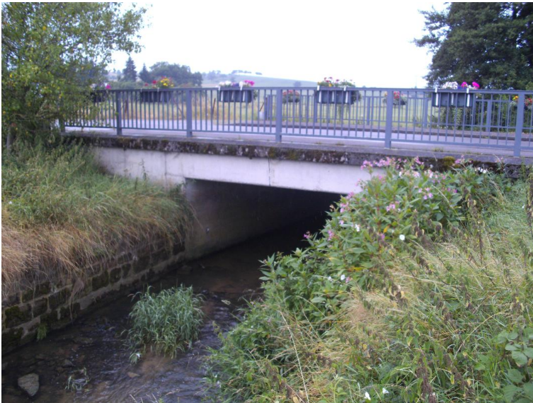
Durchlass; Ufer unterbrochen
