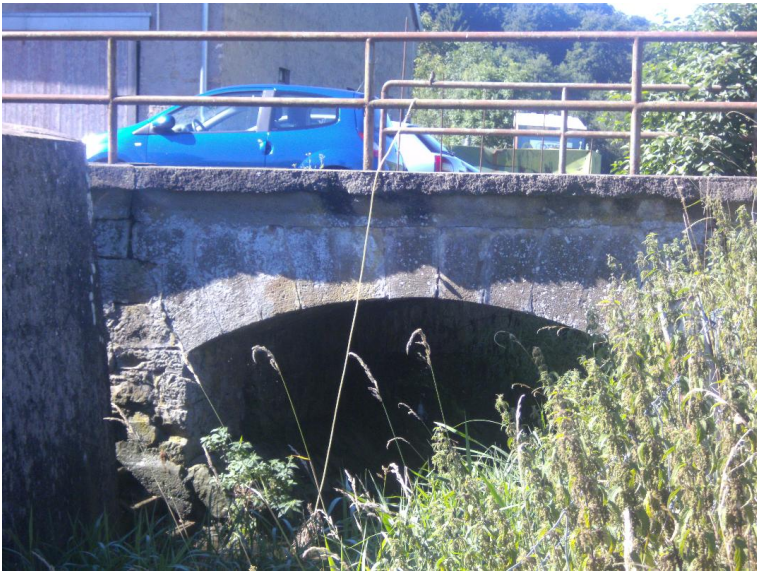
Durchlass; Ufer unterbrochen
