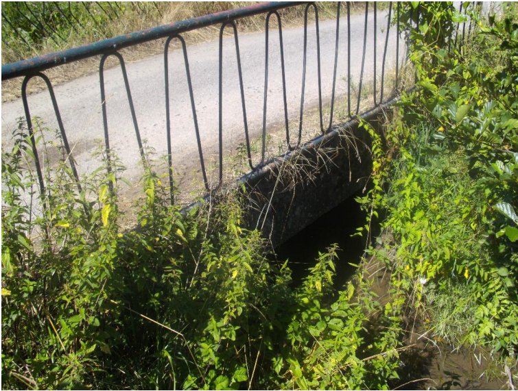
Durchlass; Ufer unterbrochen
