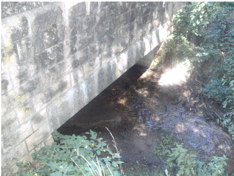
Durchlass; Ufer unterbrochen
