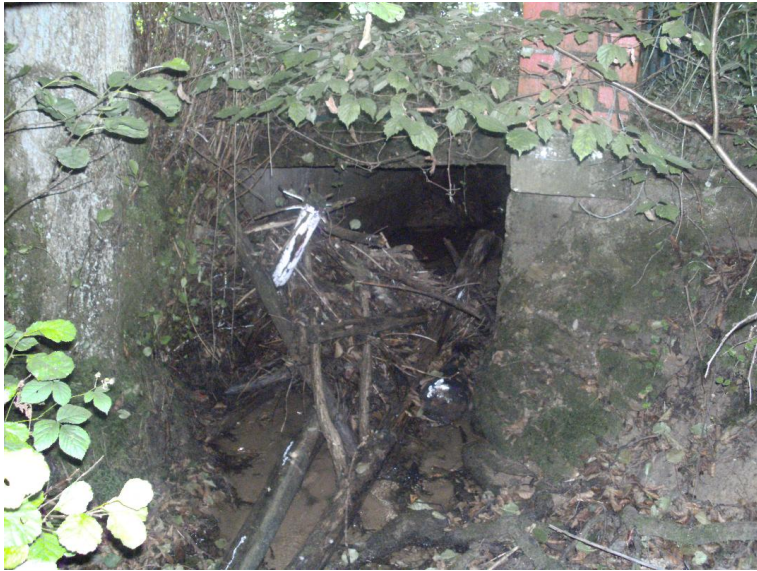
Durchlass; Ufer unterbrochen
