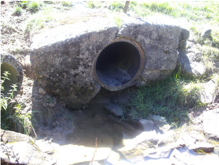
Durchlass; Ufer unterbrochen
