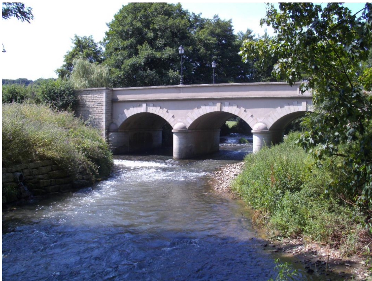
Durchlass; Ufer unterbrochen
