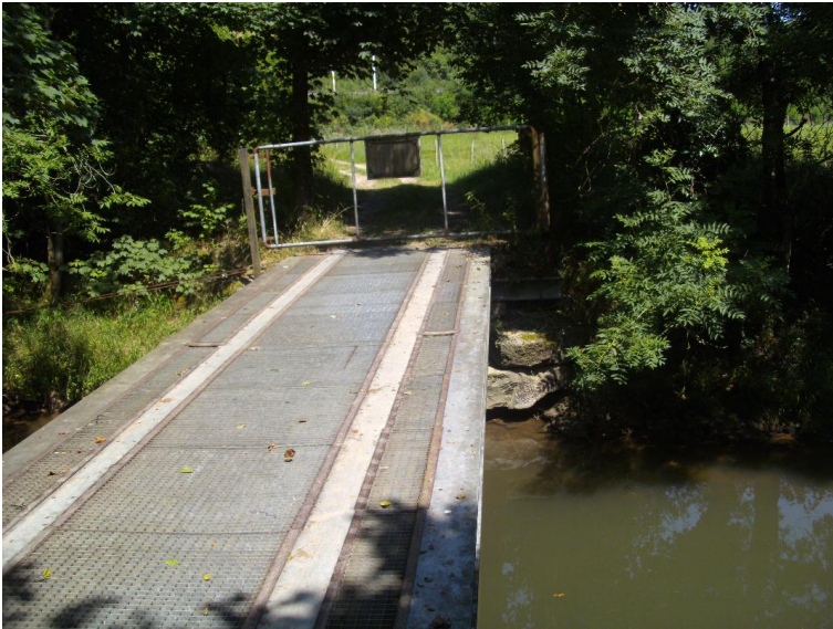
Durchlass; Ufer unterbrochen
