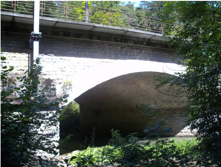
Durchlass; Ufer unterbrochen
