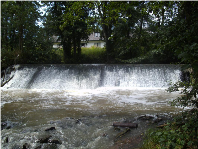
Raue Rampe mit Aufweitung
