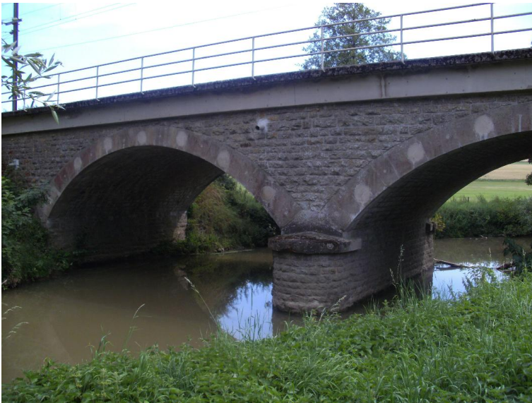
Durchlass; Ufer unterbrochen
