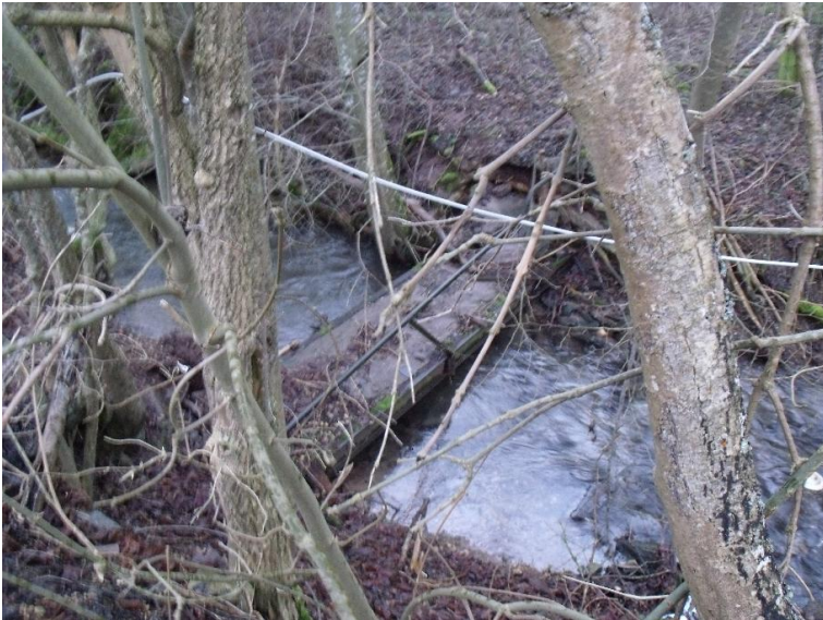
Durchlass; Ufer unterbrochen
