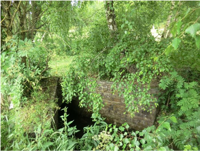
Durchlass; Ufer unterbrochen
