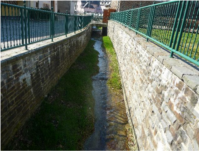
Beton, Mauer, Pflaster; verfugt
