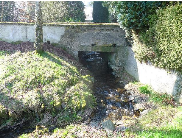
Durchlass; Ufer unterbrochen
