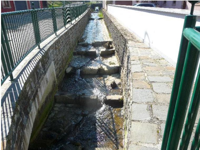
Sohlverbau durch Steinsteckung
