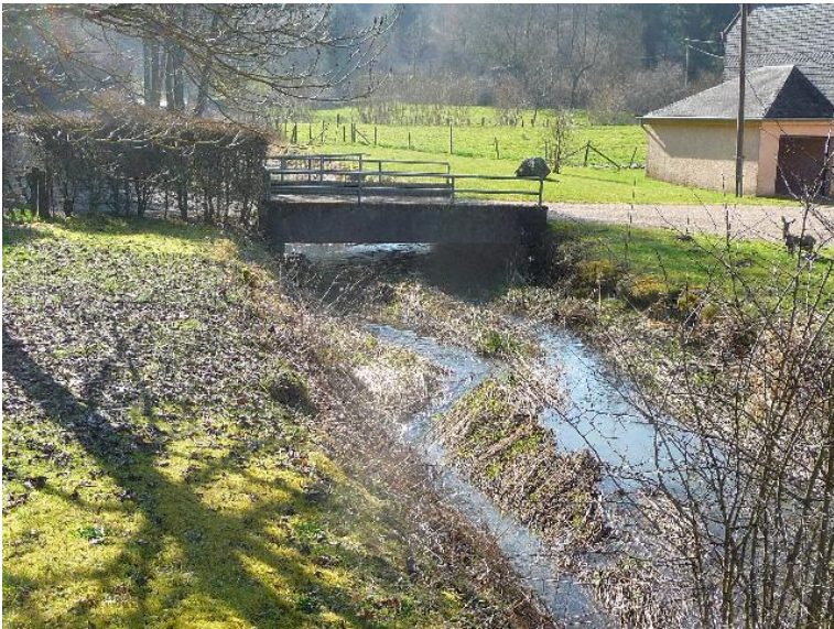
Durchlass; Ufer unterbrochen
